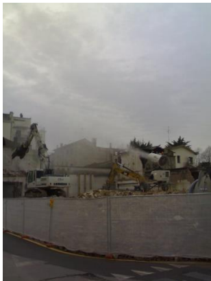
Demolizioni edifici (mc 10.000)
