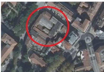
Area e fabbricati industriali Ex Pedol
