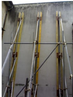
Messa in sicurezza fabbricati confinanti
