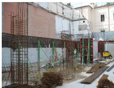
Muri (mc 630) e pilastri in c.a. (mc 120)
