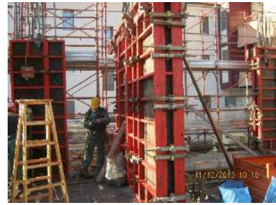
Strutture in elevazione
