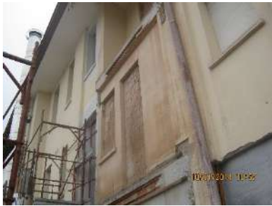
Taglio e demolizione terrazze interferenti
