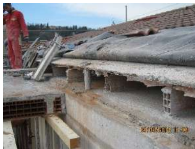
Taglio e demolizione copertura interferente
