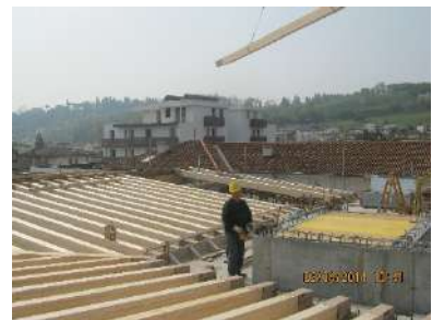
Copertura in legno
