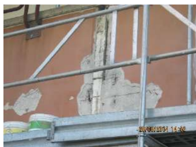
Risanamento facciate e terrazzi
