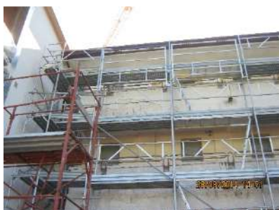
Risanamento facciate e terrazzi
