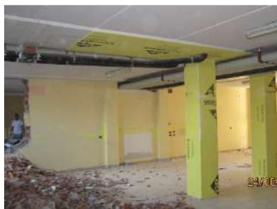
Riqualificazione strutture ai fini della prevenzione incendi
