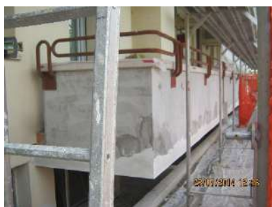
Risanamento facciate e terrazzi
