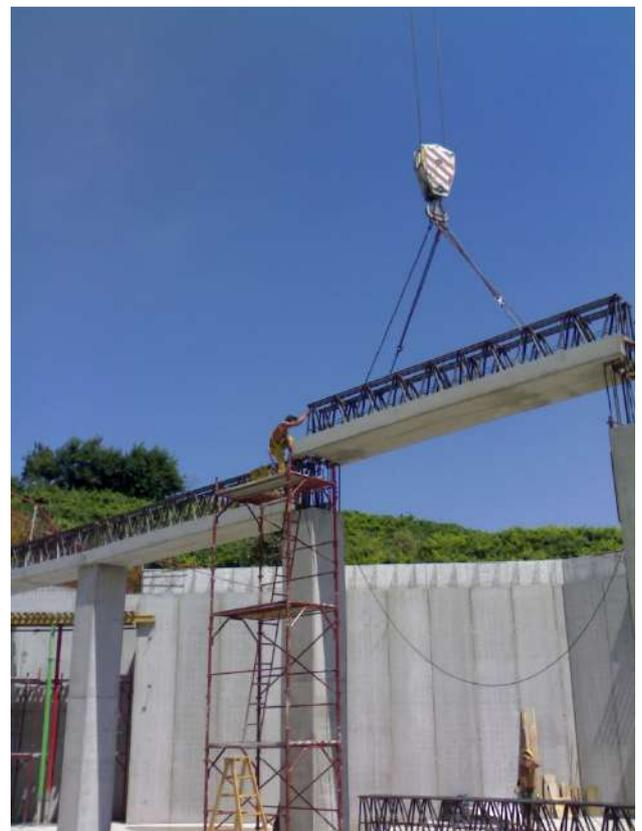
Installazione travi prefabbricate reticolari (m 102)
