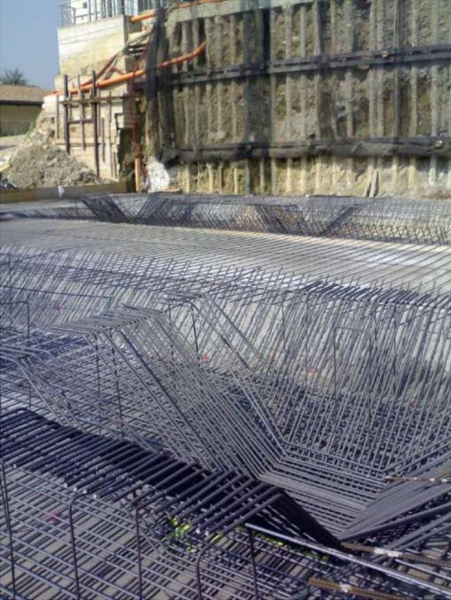
Fornitura e posa di acciaio per c.a. (kg 200.000)
