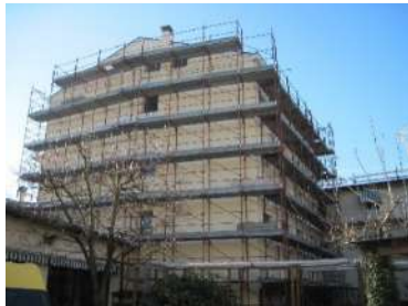
Risanamento facciate e cappotto
