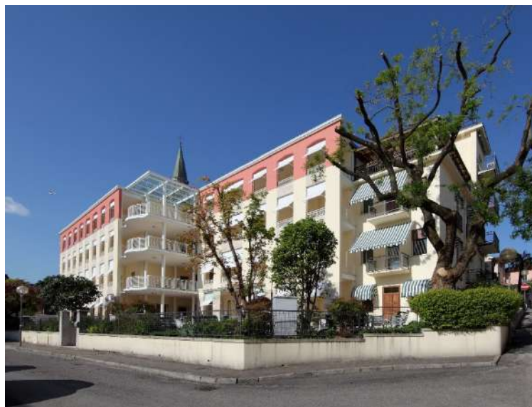
Stato finale lavori
